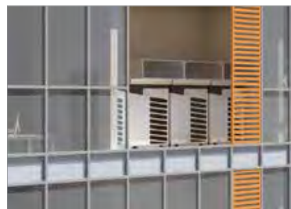
De buitenunit is verborgen in het gebouw zonder het totaalbeeld van het gebouw te beïnvloeden
