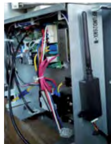
Radioadapter voor de binnenunit die op het betreffende elektronische bord moet worden aangesloten.
